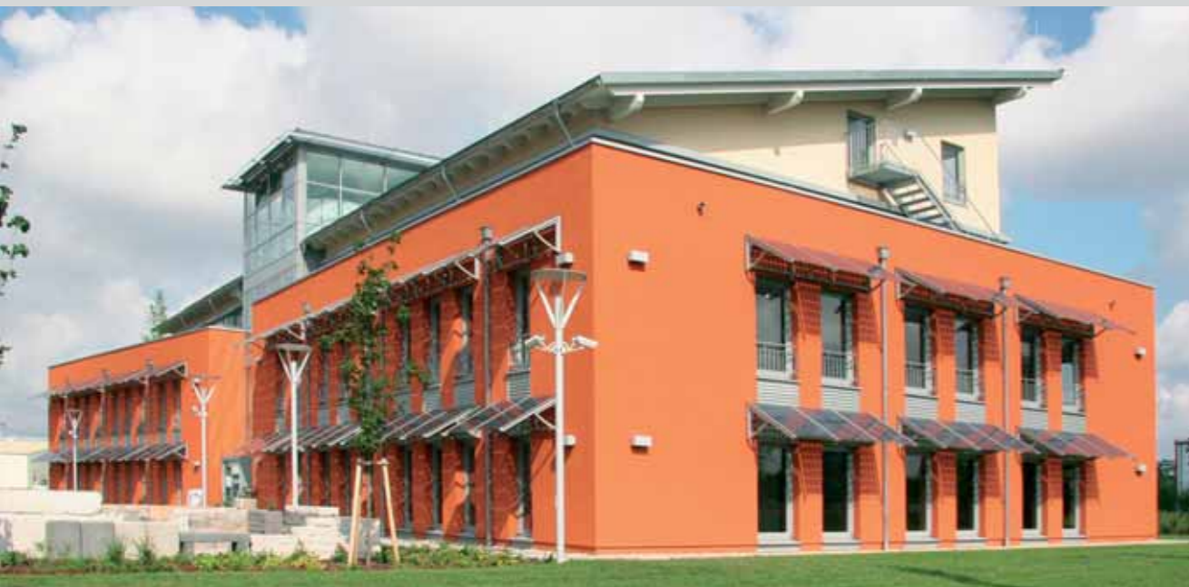
Geschäfts- und Bürogebäude
