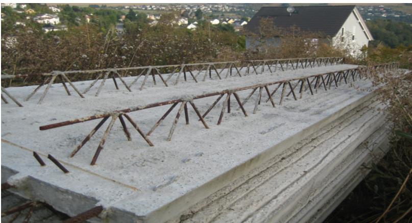
Abbildung 1: Im Werk vorproduzierte Elementplatten
