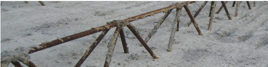
Abbildung 4: In der Elementplatte einbetonierte Gitterträger
