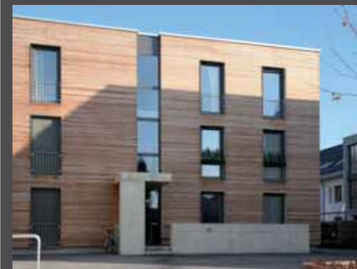
HD Wieblingen – Wohnbebauung 9.800 m 2 Variodecke / 4.500 m 2 Variowand
