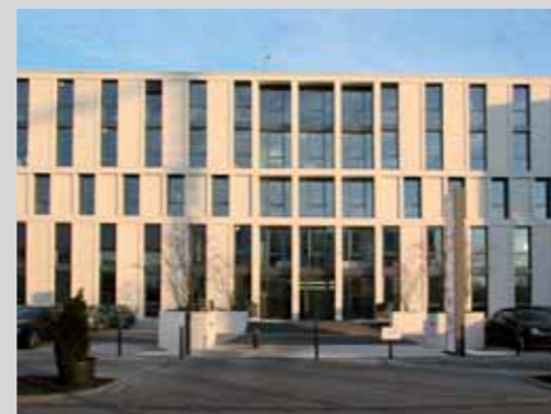
Eastside III – Bürogebäude 3.800 m 2 Variodecke / 800 m 2 Variowand
